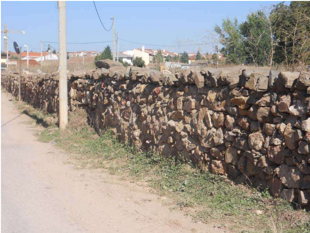
Foto 1: Muro de piedra
