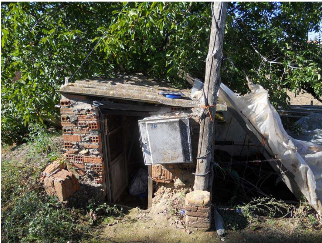
Foto 2: Pozo e instalación de bombeo
