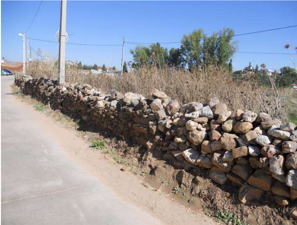
Foto 1: Muro de piedra
